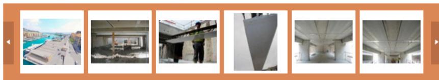
Tra i cantieri internazionali in cui trova impiego la tecnologia **Nps System**, il parking de la Douane di Nizza (Francia) è un chiaro esempio di come le criticità legate all'esigenza di costruzione in top down, tra l'altro in presenza di un terreno con scarsa portanza, sia stato risolto con l'utilizzo di travi Nps Basic e solai predalles autoportanti.
