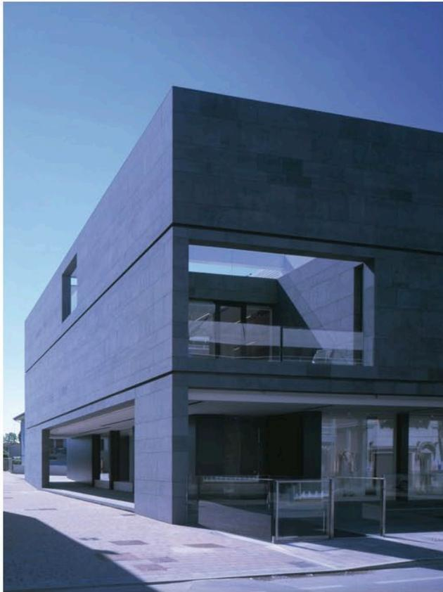
L'edificio, totalmente rivestito in pietra lavica, si sviluppa su tre livelli fuori terra e un piano interrato ed occupa un volume complessivo di 5.044 metri cubici con una superficie totale di 1.505 metri quadrati. Il piano interrato è pensato come uno spazio polivalente con pavimenti in gres e pareti in cartongesso, tutto totalmente bianco, adatto ad ospitare eventi e mostre. La luce naturale proviene da due feritoie scavate sul lato nord dell'edificio all'altezza della sovrastante via Roma.
