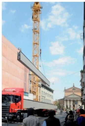
Sono state posate con un'enorme gru le sette travi d'acciaio che diventeranno l'ossatura portante per la copertura del teatro Astra. Ieri via Ancillotto chiusa al traffico, ma non ai pedoni che hanno potuto assistere allo spettacolo.
