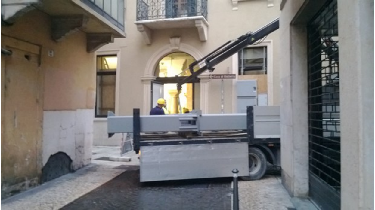
Cantiere con spazi ristretti
