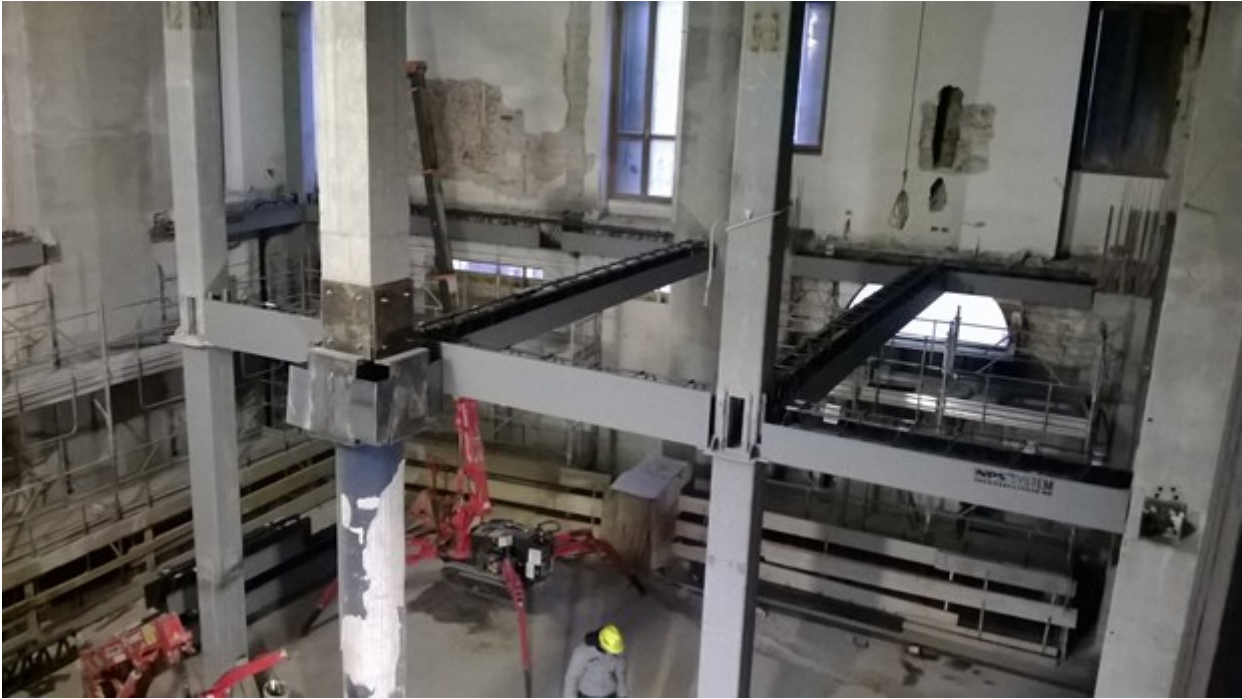
travi e pilastri NPS
