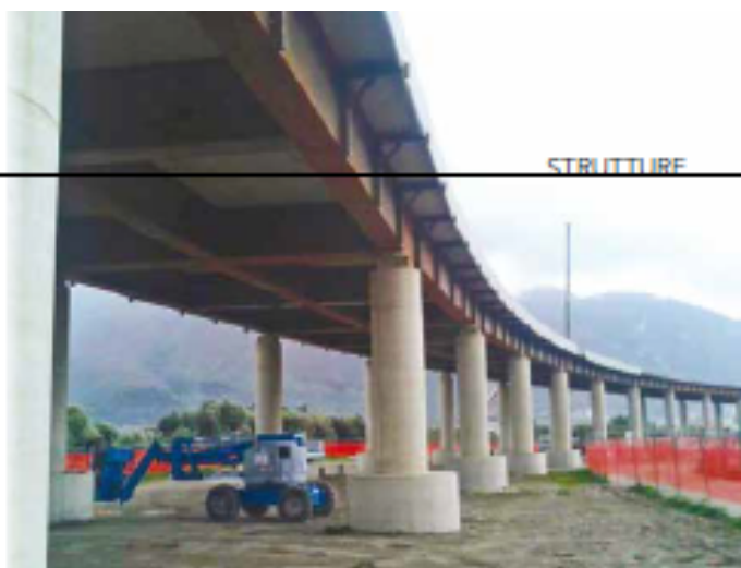
3. Una foto dei lavori in corso sullo svincolo di Anghi
