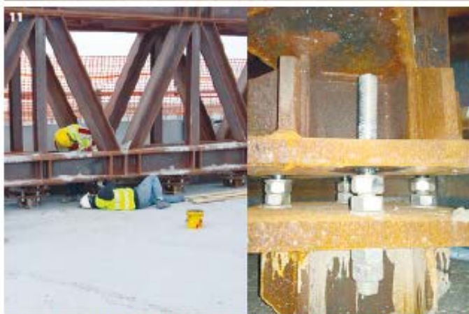
Fig. 9 - Montaggio travi basic NPS ® appese. Fig. 10 - Trasporto trave reticolare. Fig. 11 - Sgancio delle travi BasicNPS ® dalla reticolare e relativo abbassamento
