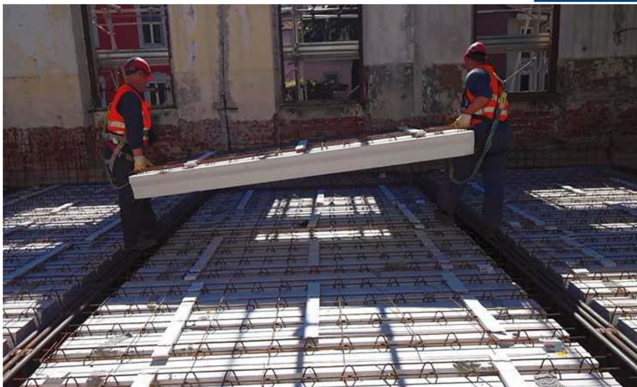
11/01/2017 - E' [Airfloor™](#) la soluzione ideale per ogni tipo di sopraelevazione. Il nuovo solaio autoportante **Airfloor™** è veloce da installare e si adatta a tutte le possibili geometrie di progetto. Con un peso a secco inferiore ai 50 kg/mq, è autoportante fino a 5,6 metri.
