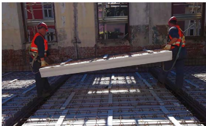
Posa Solaio Airfloor
