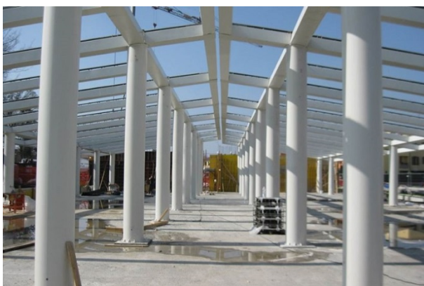
Figura 2. Le due strutture realizzate con travi e pilastri NPS® scelte per l'analisi LCA
