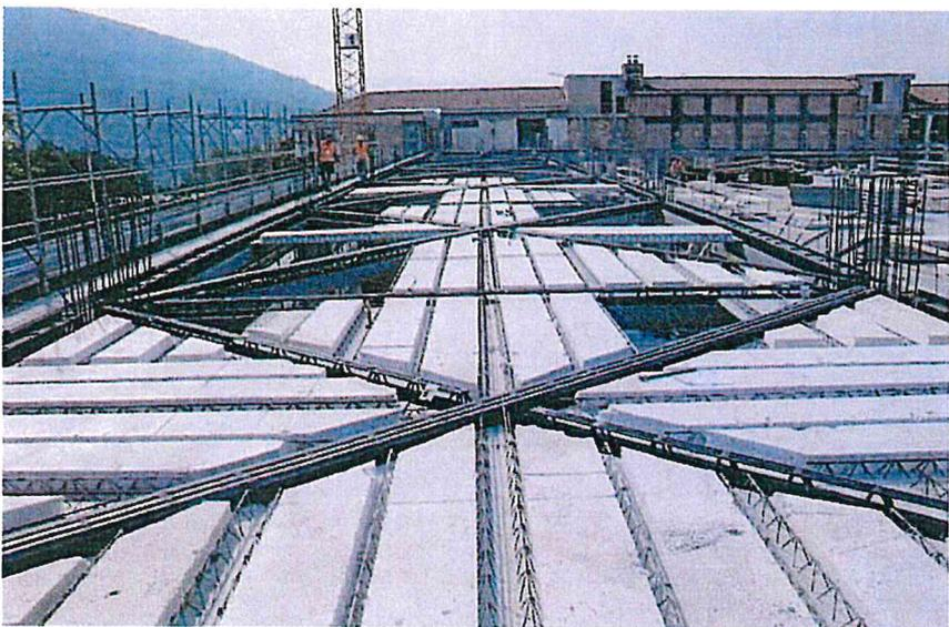
Grazie al sistema costruttivo NPS® sono stati trasmessi alle strutture verticali i carichi dovuti ai solai in fase di getto senza la necessità di strutture provvisorie, con una riduzione notevole dei tempi, mediante l'adozione di uno schema strutturale a croce che ha permesso da un lato di concentrare le azioni verticali in minori appoggi verticali e dall'altro di controventare le campate dei solai e ottenere un effettivo irrigidimento dell'impalcato.
