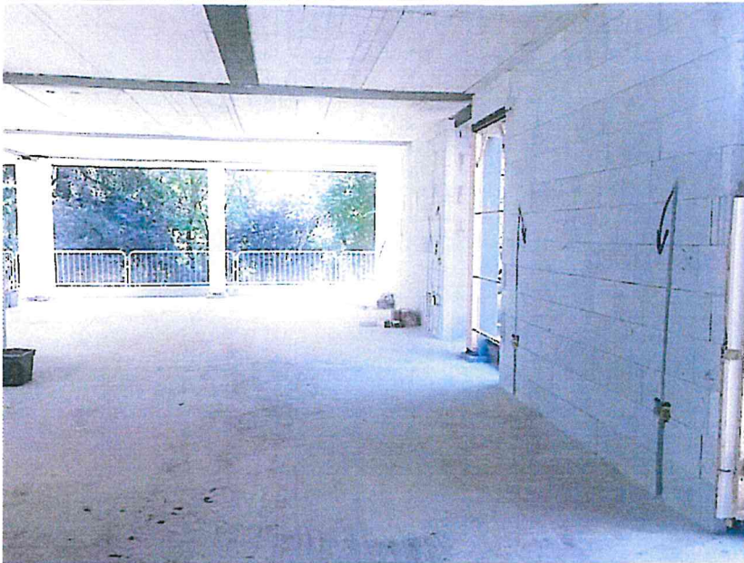
Tecnostrutture spiega come sopraelevare un edificio esistente
