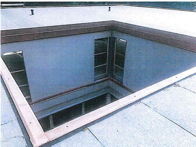
Tecnostrutture spiega come sopraelevare un edificio esistente
