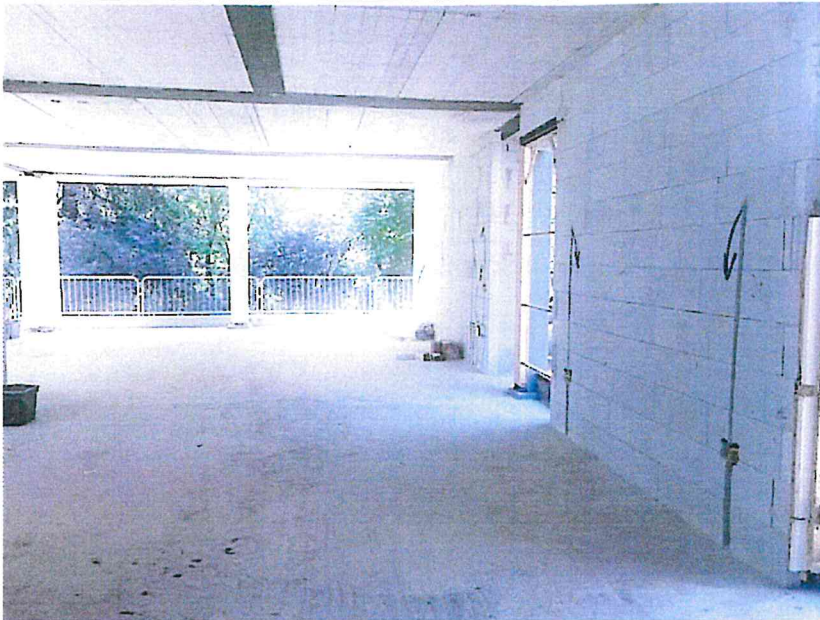
Tecnostrutture spiega come sopraelevare un edificio esistente
