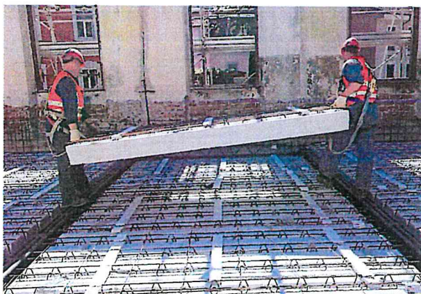
Il solaio Airfloor si adatta a tutte le geometrie di progetto. Può essere customizzato nelle sue dimensioni a seconda delle necessità ed è disponibile in sottomultipli.
