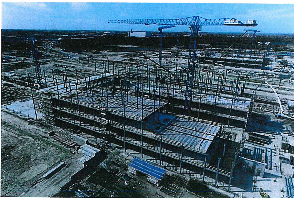
Stato di avanzamento dei lavori Ospedale universitario di Odense, Danimarca. Photo credits: Nyt OUH.
