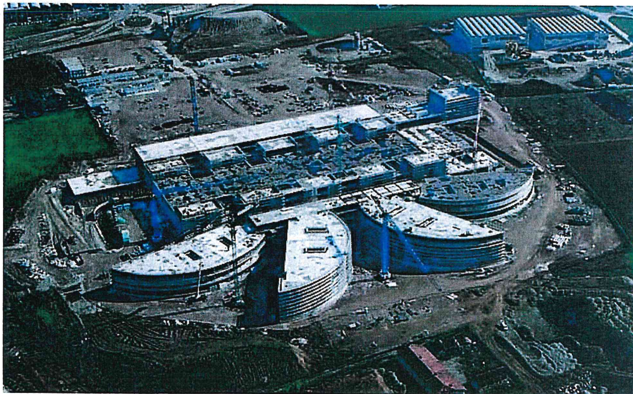
116.000 mq di impalcato realizzati in 6 mesi, Ospedale Vimercate
