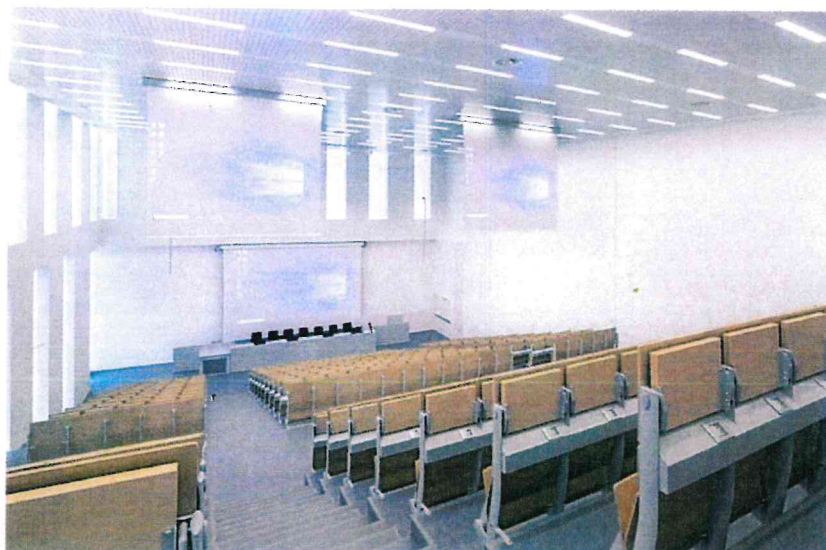
Travi NPS® abbinata a solaio alveolare per la copertura dell'aula magna con soffitto inclinato. Foto di Andrea Serra © Studio Pession
