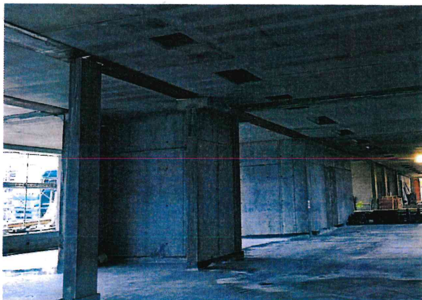
Travi NPS® abbinata a solaio predalles per la realizzazione di pozzi di luce a soffitto
