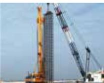
NPS Dia è un pannello reticolare in acciaio che contiene il terreno durante lo scavo.
